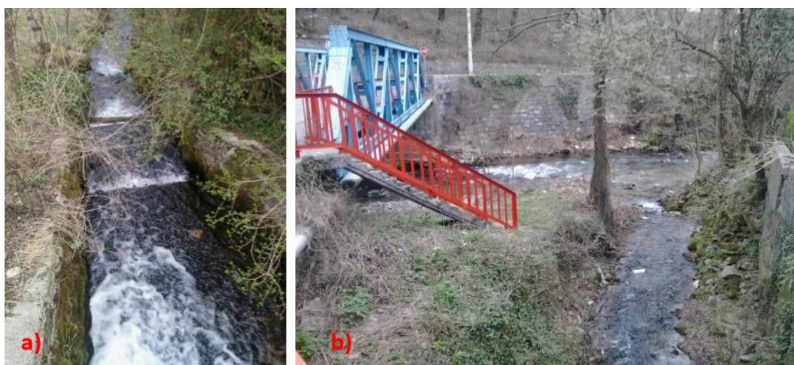
Slika 7. a) Dionica toka rasteretnog bočnog odvojka kanala neposredno uzvodno od kola MHE b) najnižvodnija dionica toka odvojka kanala za MHE s ušćem u Rječinu nizvodno od mosta na Trnovici
