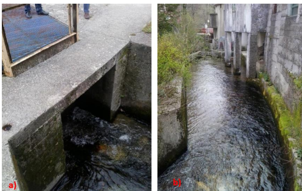
Slika 5. a) Izlazni dio derivacijskog odvojka kanala ka MHE sa zatvaračem b) nastavak kanala ka kolu MHE
