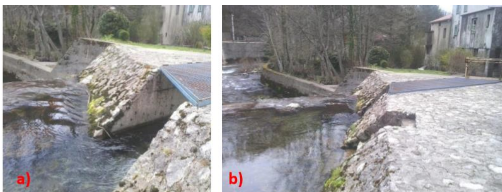
Slika 4. a) Ulazni dio derivacijskog kanala MHE b) najuzvodniji dio derivacijskog kanala ka MHE sa zapornicom na rubu obalnog zida
