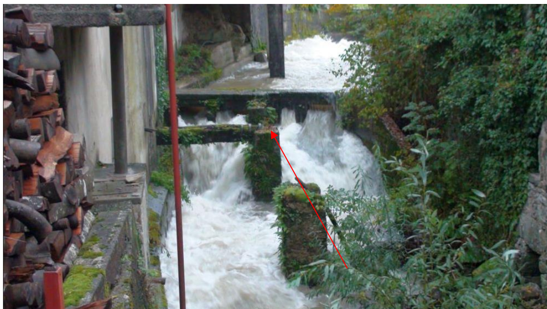
Slika 6. Pogled s nizvodne strane – vidljiva distribucija protočnih voda kroz glavni tok odvojka i na samo mjesto (strelica) novog čeličnog kola MHE
